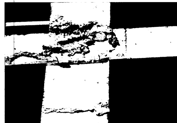
Foto N° 20: Segregación y deficiente terminación de pilares de hormigón arquitectónico en eje 1
