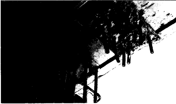
Fotos N°s 1 y 2: Deficiente amarre de enfierradura de pilares corregidos en tercer piso.
