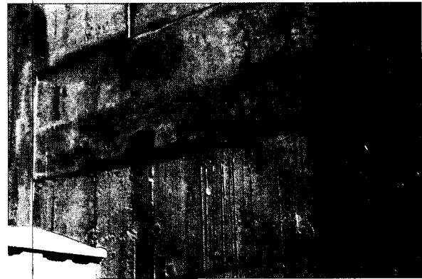
Foto N° 10: Enfierradura a la vista, caja escalera entre ejes 12 y 13, primer piso.
