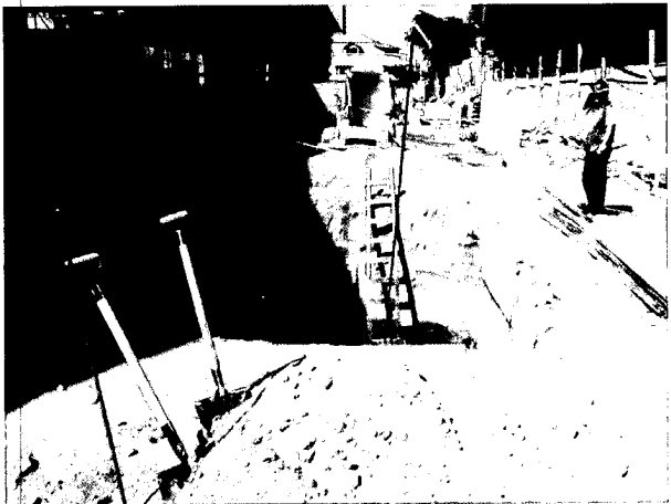
Fotos N°s 5 y 6: Ausencia de señalización en excavación. Fotos del 19 de febrero de 2014.
