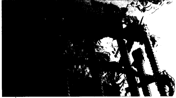
Fotos N°s 1 y 2: Deficiente amarre de enfierradura de pilares corregidos en tercer piso.
