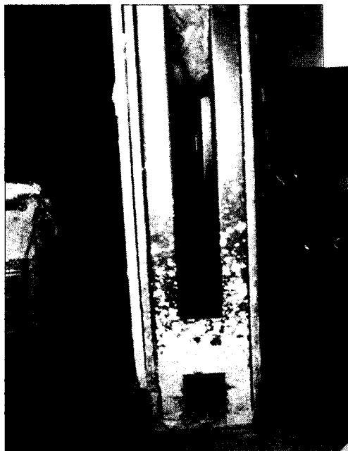
Foto N° 25: Aislación incompleta en tabique.
